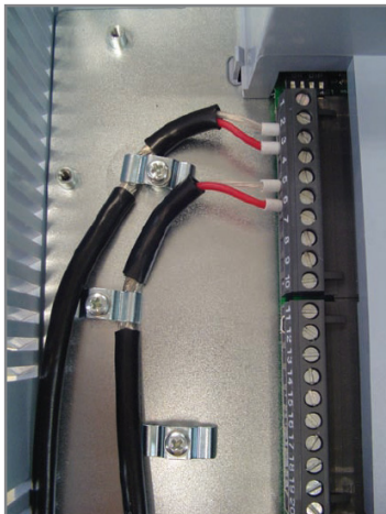
Figura 3: Ejemplo de conexión del blindaje de los cables de control (en ese caso fue presentado el ejemplo de cables conectados en XC1, más el mismo se aplica a los cables conectados en XC25)
