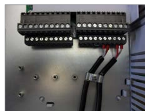
(b) Ejemplo de conexión del blindaje al punto de tierra
