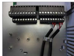
(b) Exemplo de ligação da blindagem ao terra
